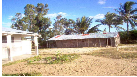
Le nouveau et l'ancien bâtiment
