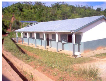
Bâtiment CRP avec panneau solaire
