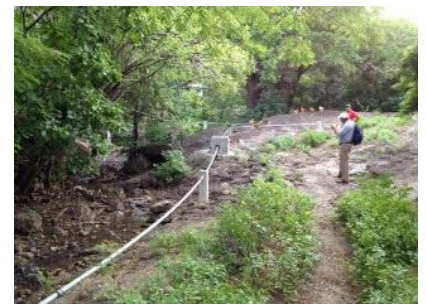
Ajustes sobre la marcha a líneas de distribución en Comunidad el Limón
