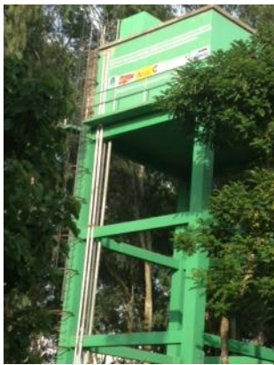
Tanque elevado en Comunidad El Gancho
