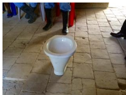
Obra sobredimensionada y mala calidad de materiales en la Ceiba.
