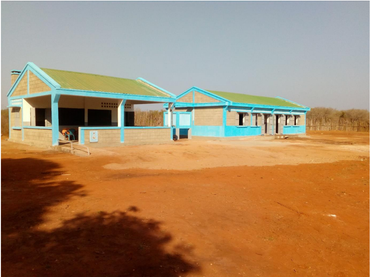
Vue d'ensemble de 2 salles de classe
