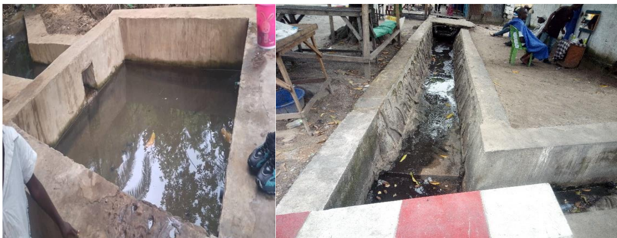
Pose des bordures (caniveaux) à Ndjili – ABAKHIN
