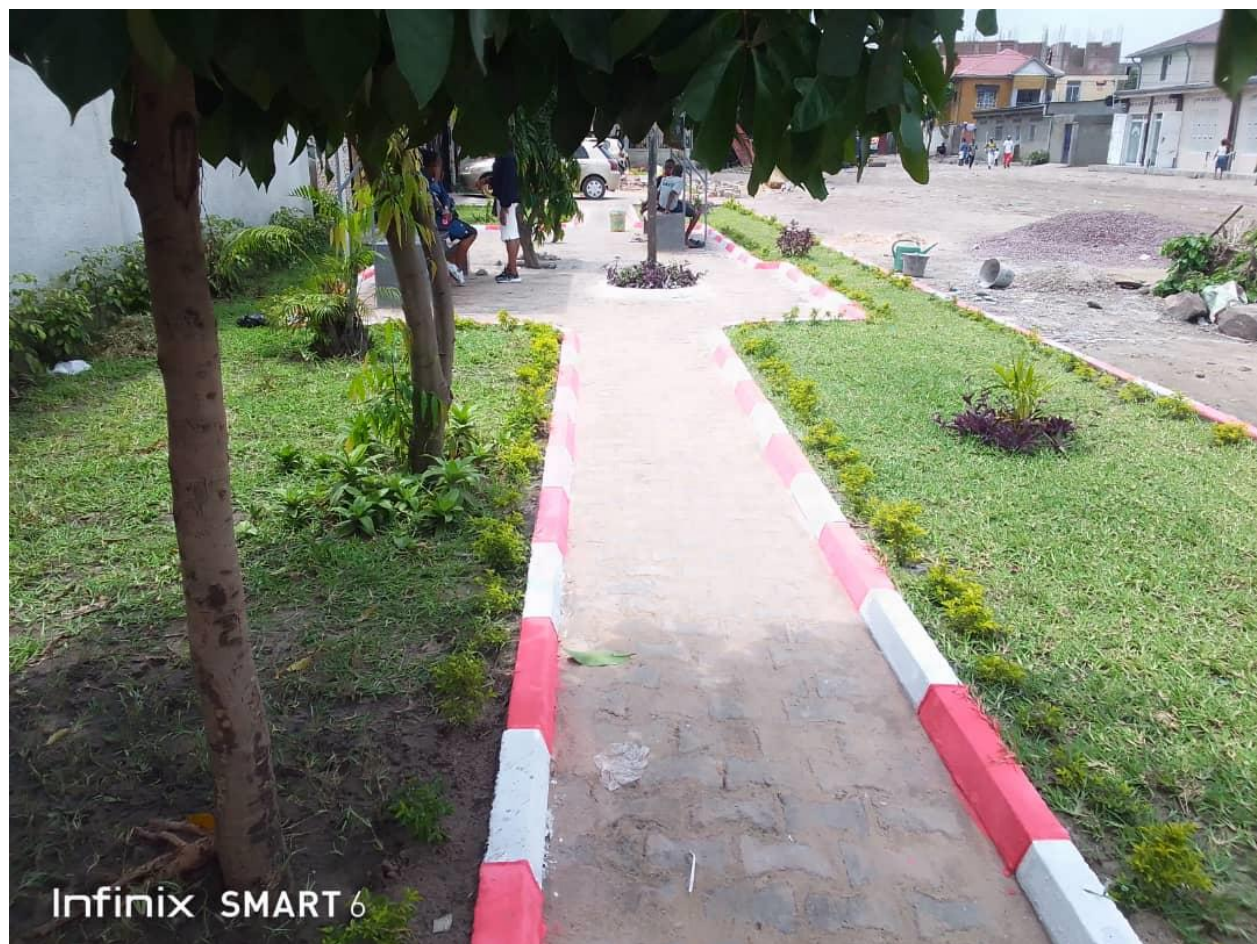
Aménagement d'un espace public à Ndjili
