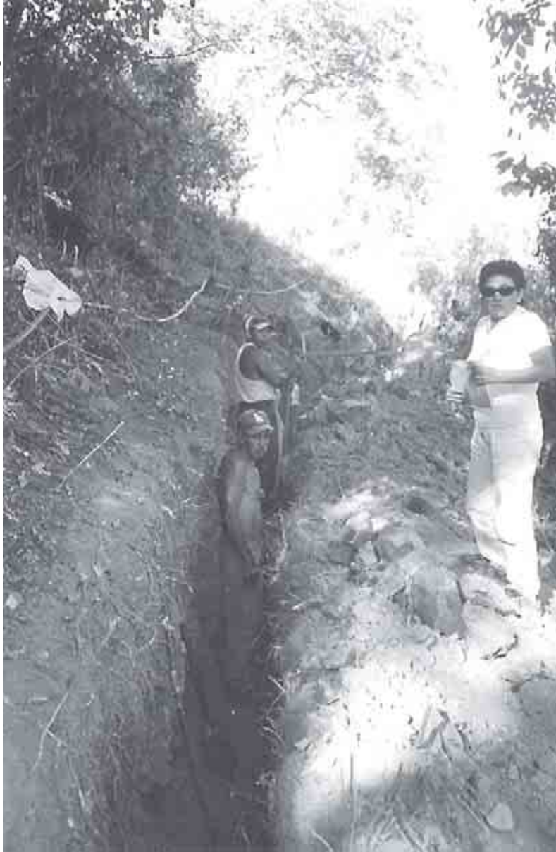
Microempresa construyendo canal de riego.
